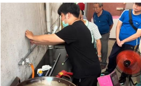
延伸水管固定
