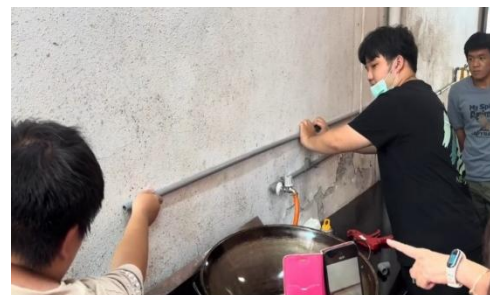
加裝延伸水管
