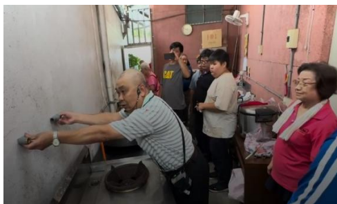
量測加裝延伸水管
