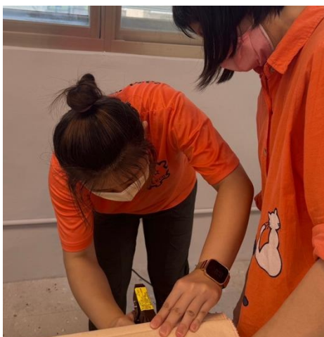
場域改造-現場施工
