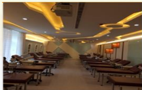
化妝品系護膚 專業教室改建工程
