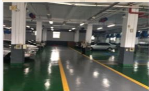
車輛工程系 乙級證照場所新建工程
